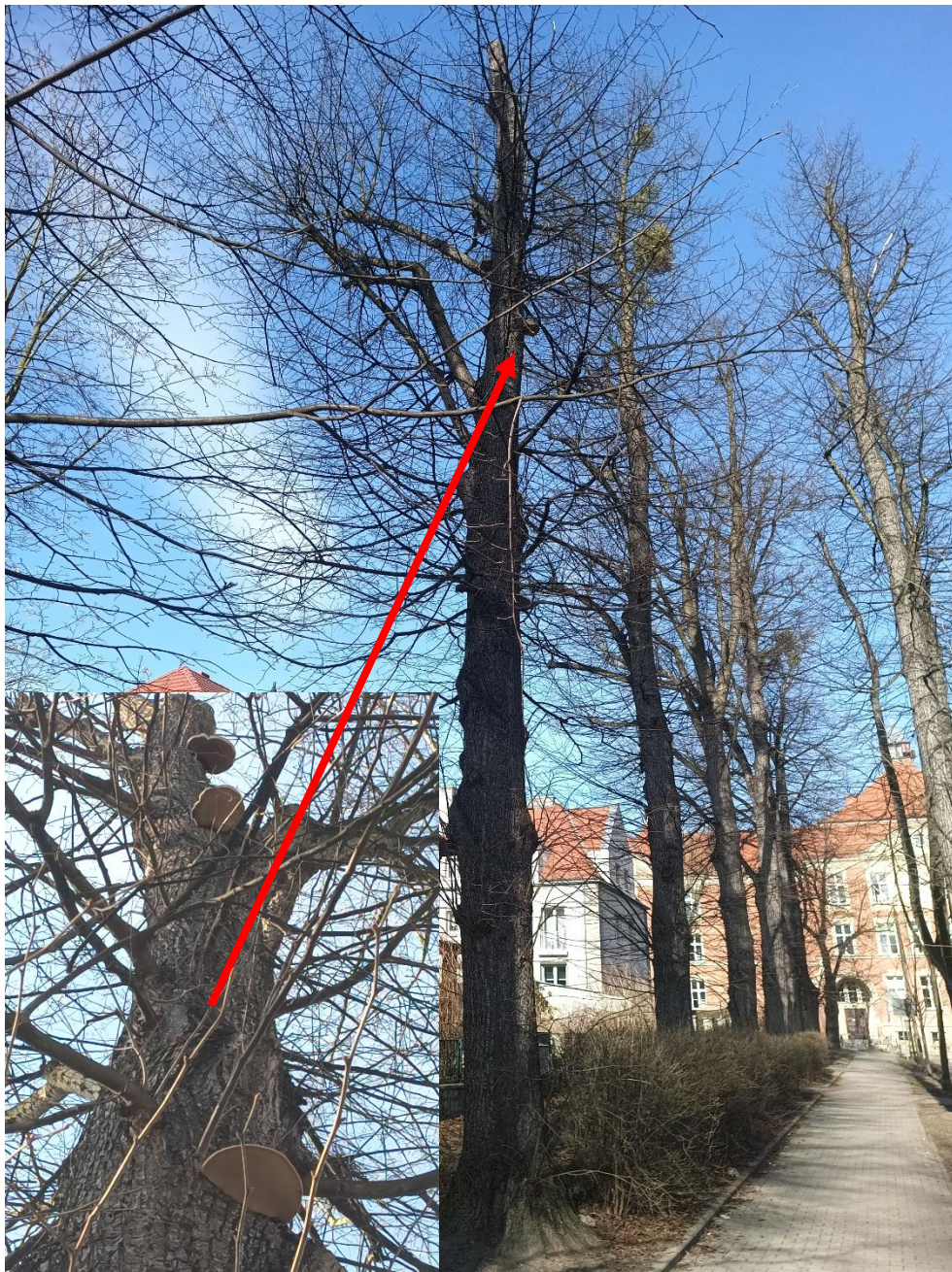
Fot. 1 ul. Karola Miarki - nr inw. 1. Liczne owocniki hubiaka pospolitego, rozkład drewna, ryzyko złamania pnia
