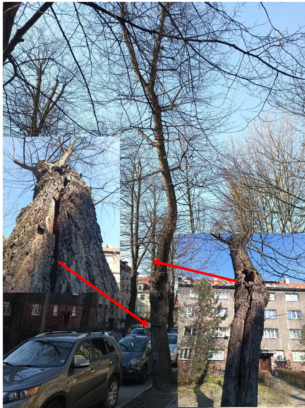
Fot. 10 ul. Karola Miarki - nr inw. 10. Otwarte wypróchnienie kominowe od podstawy do wysokości ok. 3,5 m
